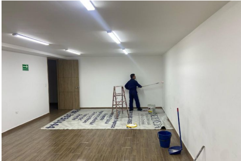
Mantenimiento Pintura Aulas 1er. Piso Sede A - Bogotá.
