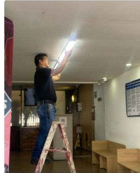
Mantenimiento y Cambio de Luminarias Sedes A y B - Bogotá.
