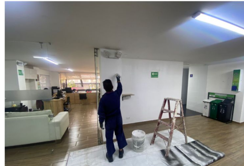
Mantenimiento Pintura Pasillos Hall 1er. Piso Sede A - Bogotá.
