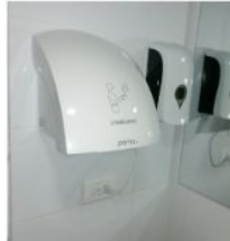
Instalación Secadores de Mano Baños Sede A - Bogotá.
