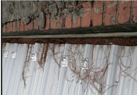
Limpieza de Canales de Agua Lluvia Sede A - Bogotá.
