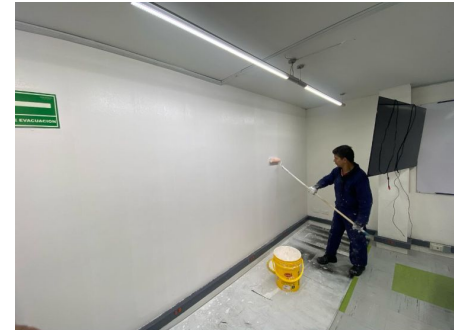
Mantenimiento Pintura Aulas 2do. Piso Sede A - Bogotá.
